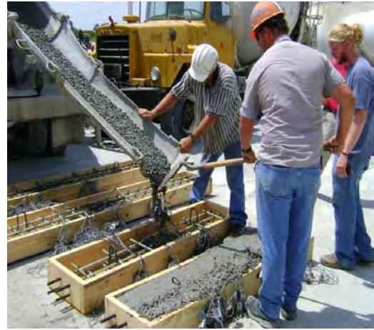
(d) Casting concrete
