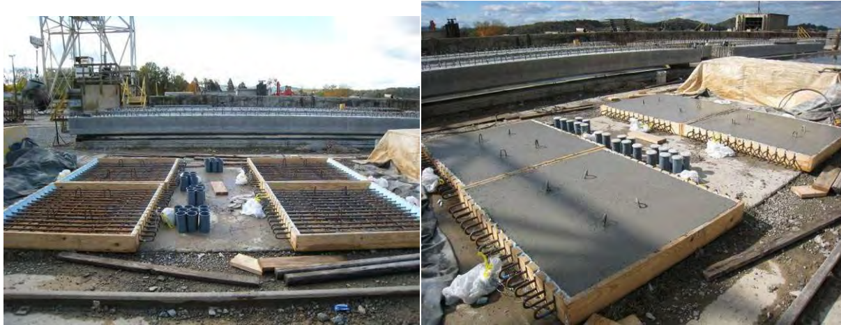
(a) Before pouring (FS & SS Specimens)
