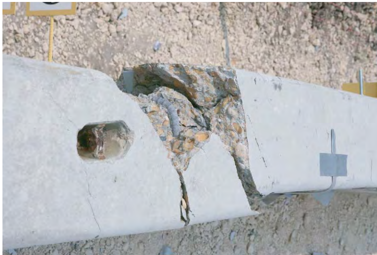
(d) Closeup side view of the barrier
