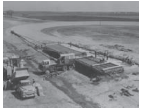
Pouring slab for test bridge.
